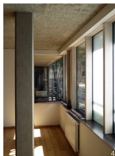
OSB-geschaltete Decke im Wohnhaus Straße
