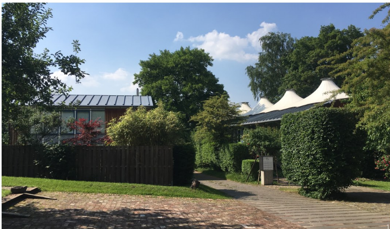
Blick in den „Stadtgarten“ auf Einfamilienhaus und Textil-Dach des Mehrfamilienhauses
